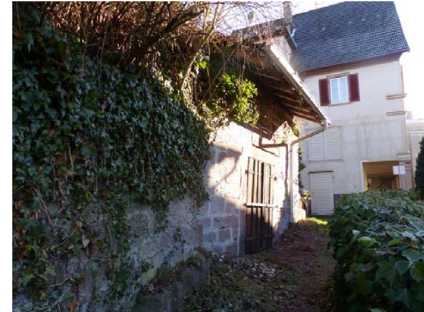
Altensteig, Hanfgässchen 23 u. Bädegässchen
