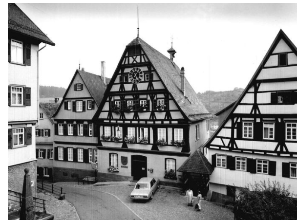
Paulusstraße 4 Ansicht Nord-Ost
