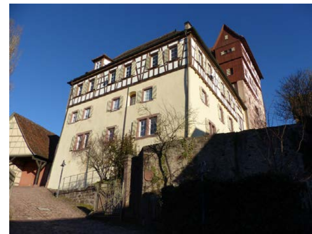
Altensteig, Kirchstraße 11/1, Neues Schloss
